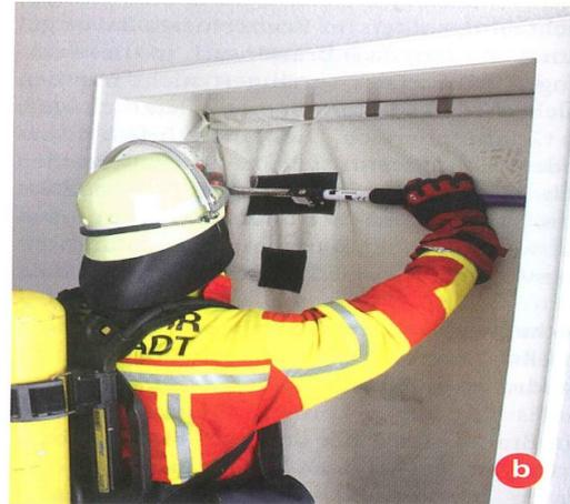
... anschließend wird die Spannstange ausgezogen, bis der Rauchverschluss auch links bündig an der Türzarge ansteht.
