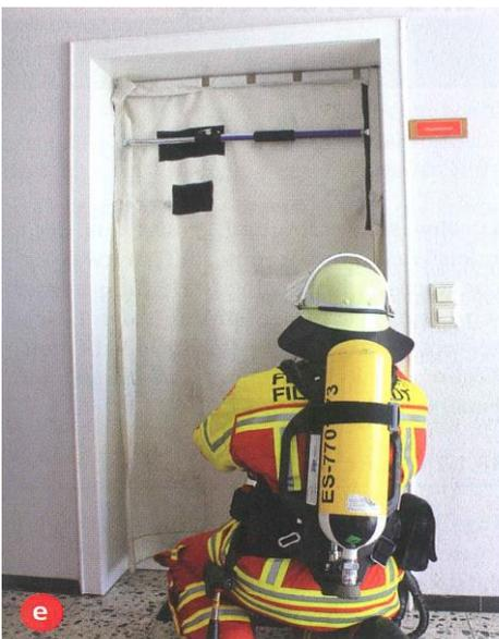
Vollständig installierter mobiler Rauchverschluss.
